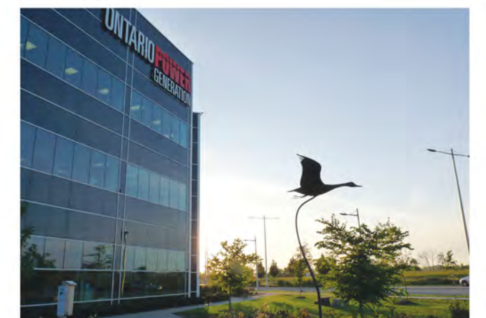
OPG Darlington Energy Centre
