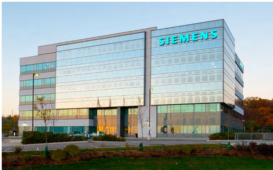
Office (Siemens, Oakville)
