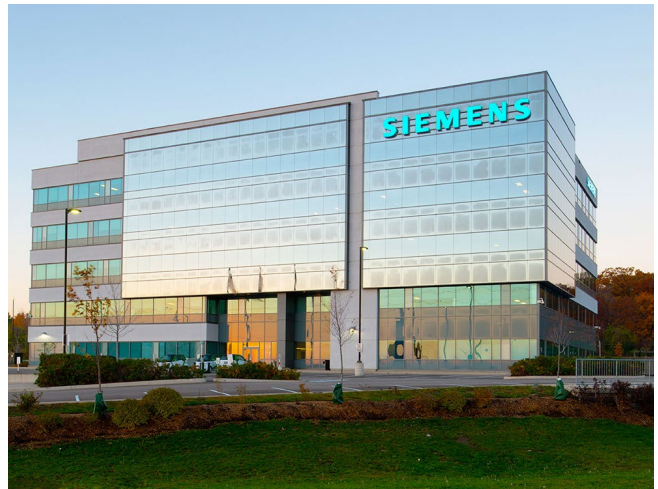
Office (Simens, Oakville)
